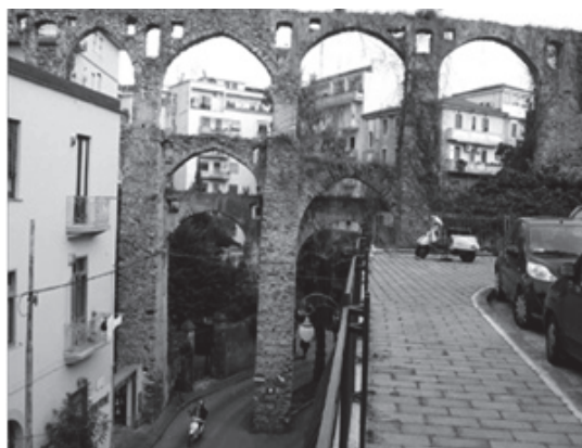
Fig. 2. Salerno, Acquedotto di via Arce
