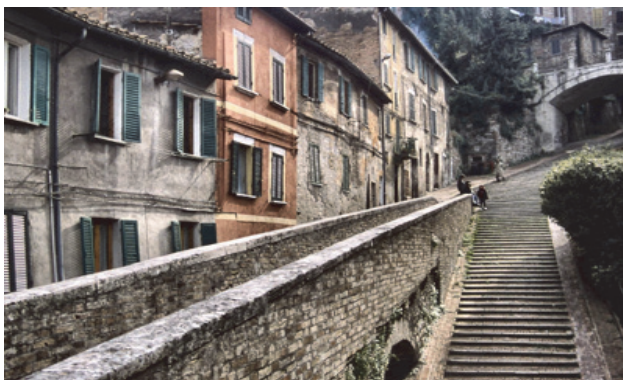
Fig. 9. Perugia, Via Acquedotto, resti dell'acquedotto medievale (XIII secolo)
