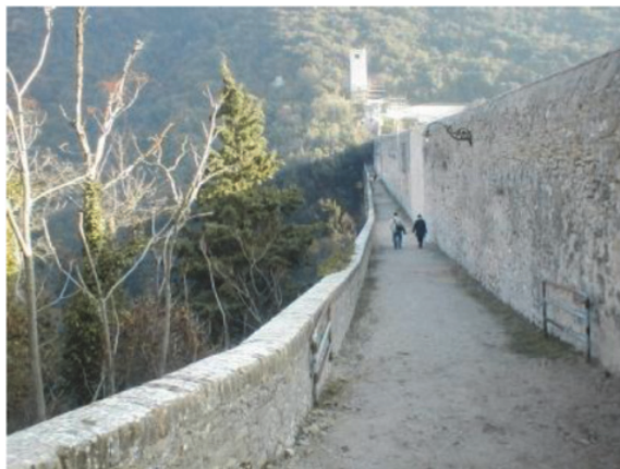
Fig. 4. Spoleto, Ponte-acquedotto, detto Ponte delle Torri, percorso stradale. L'alto muro contiene il canale per l'adduzione dell'acqua.
